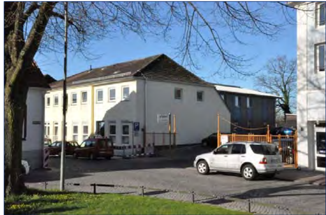
Das künftige Kirchliche Verwaltungszentrum des Kirchenkreises Ostholstein in der Königstraße, Neustadt in Holstein, am 18. April 2011. Foto: Döbler
